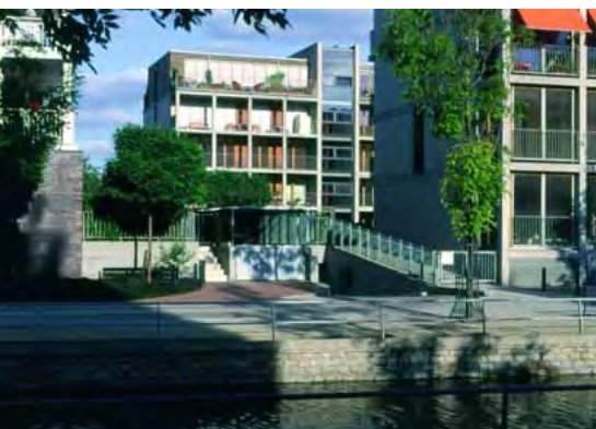
Nye attraktive bebyggelser på omdannede havneområder. Til venstre Duisburg, i midten Helsinki og til højre Helsingborg.
